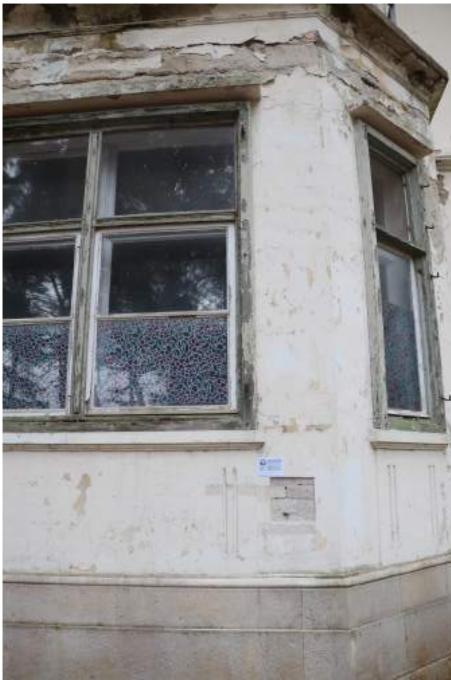
Sonda br. 3 na mjestu erkera koji je naknodno izveden na južnom pročelju objekta
