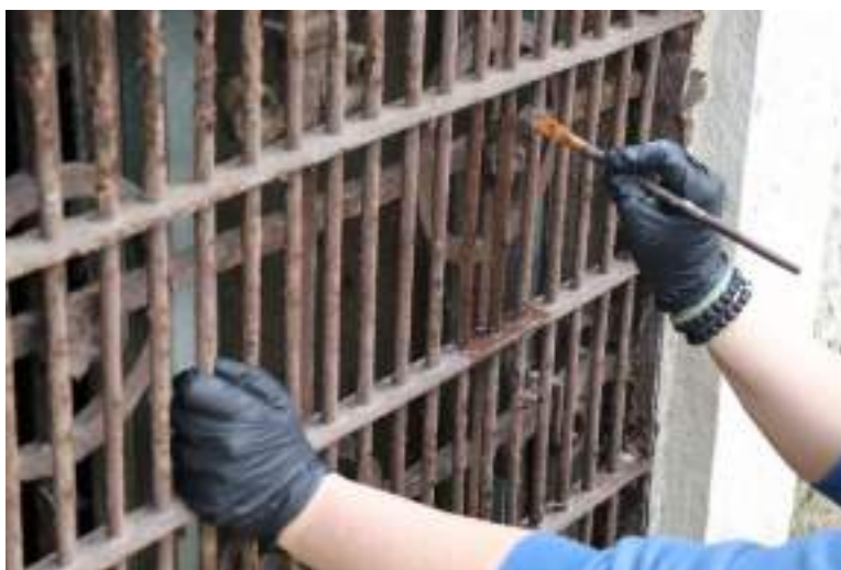
Nanošenje otapala za lažše uklanjanje bojenih slojeva s metala
