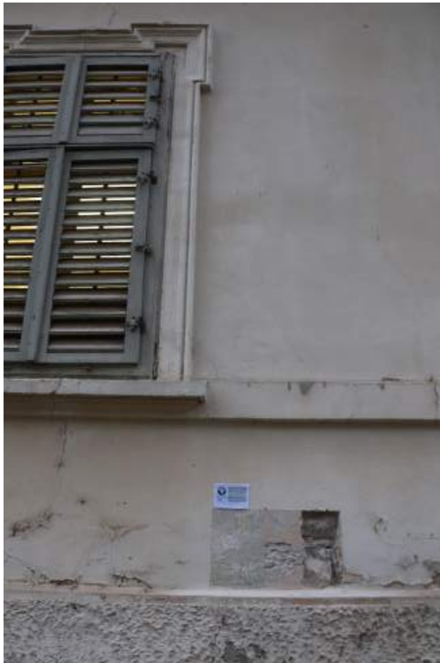
Zapadno pročelje s izvršenom sondom br. 2
