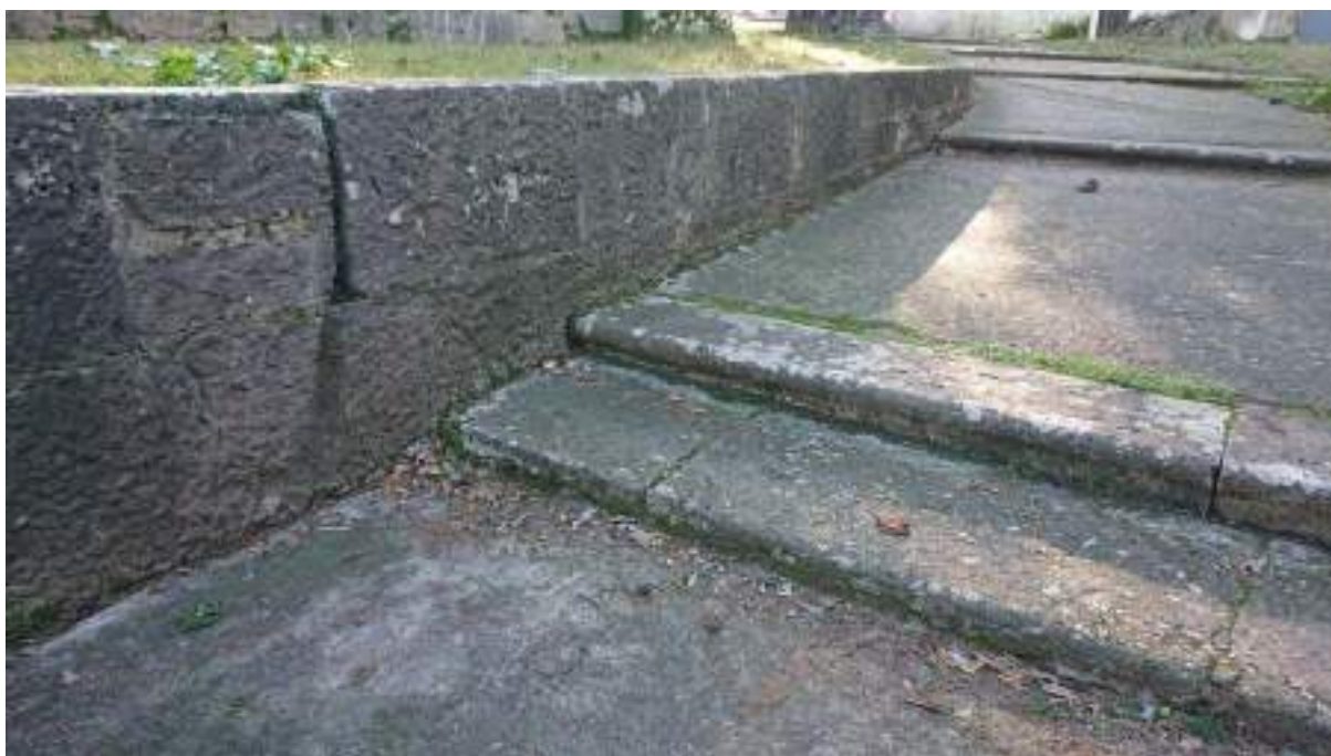
Sjeveroistočna staza koja vodi do vile s kamenim pragovima (A), betonskim podestima krupnije granulacije i zidom od klesanih blokova (D)
