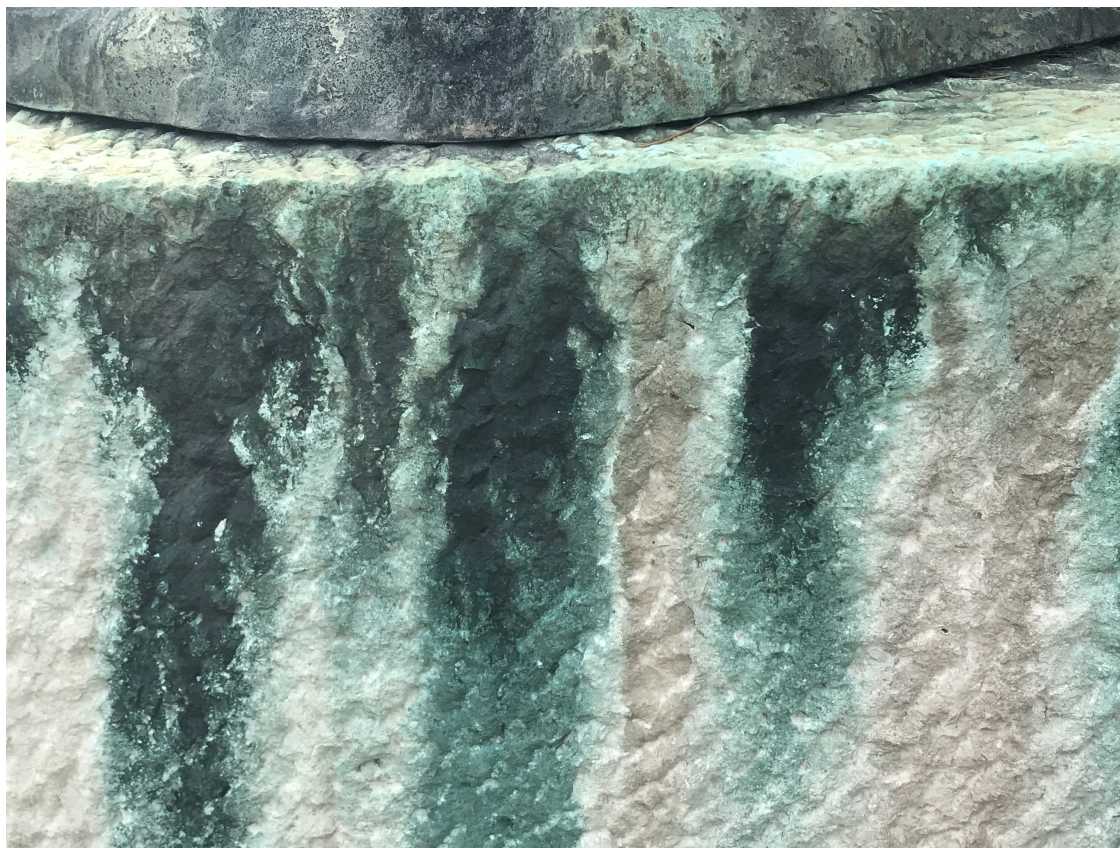
Sl.13. Zatečeno stanje, detalj malahitnih obojenja kamena
