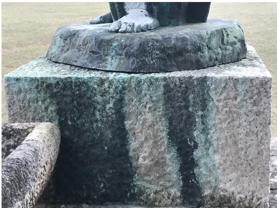
Sl.12. Zatečeno stanje, pogled na prednju stranu kamenog postamenta
