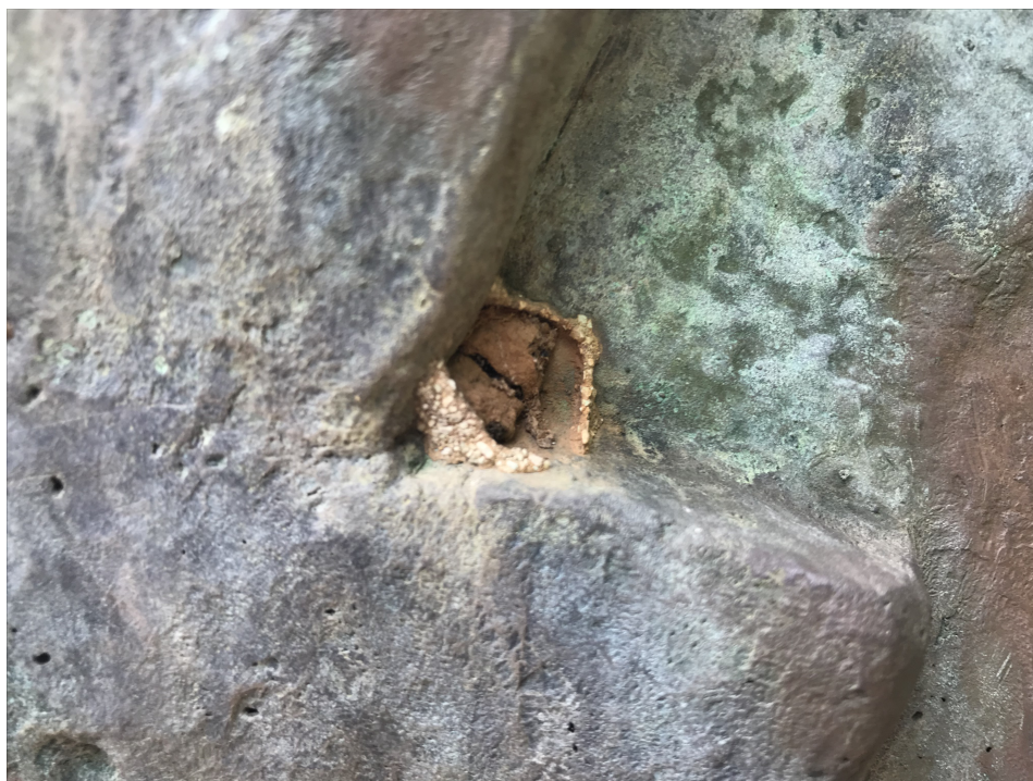
Sl.28. i 29. Zatečeno stanje, onečišćenje nastalo zbog životinja (osinje gnijezdo)
